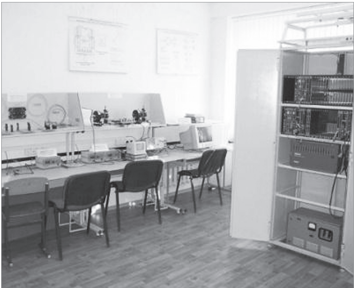
Лаборатория «Волоконно-оптические линии связи»
